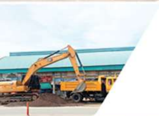
บริเวณคลองบรมธาตุ จุดแยกไฟแดงศาลหลักเมือง ถึงแยกไฟแดงทุ่งที่
